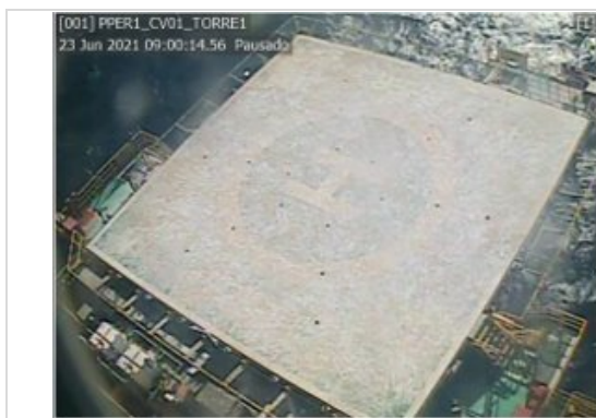
Figura 1 - Guano prejudicando a visibilidade das marcações de segurança do helideque.
