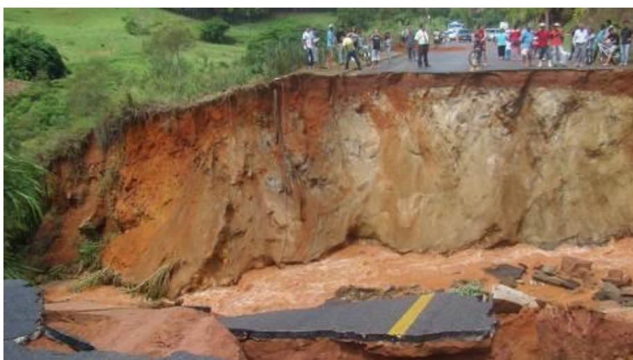
Figura 15 – Colapso de aterro rodoviário na rodovia ES-482.
