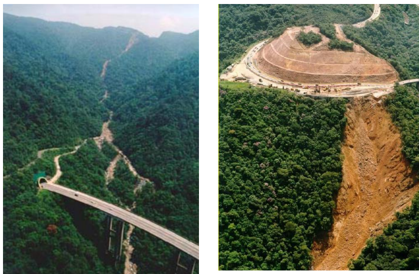
Figura 7 – Escorregamento ocorrido na Serra do Mar, em São Paulo. Na figura à esquerda observa-se a pista de descida da Rodovia dos Imigrantes. A figura à direita mostra um detalhe da cicatriz de escorregamento próxima da Rodovia Anchieta [4].
