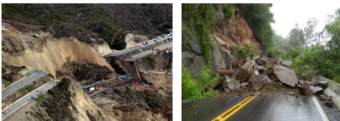
Figura 8 – À esquerda, escorregamento catastrófico na rodovia que liga Tijuana à Ensenada (México). À direita, queda de blocos na BR-116.
