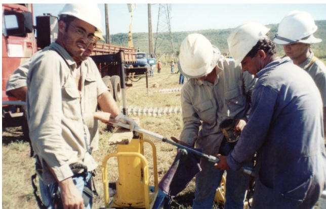
Fig 9 – Execução de emenda de cabos condutores de linha de transmissão. (Fonte: dos autores deste artigo)
