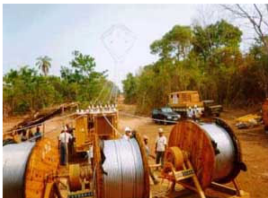
Fig 8 – Praça de lançamento de cabos condutores de linha de transmissão. (Fonte: dos autores deste artigo)
