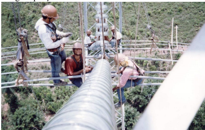
Fig 10 – Execução de grampeação de cabos condutores de linha de transmissão. (Fonte: dos autores deste artigo)
