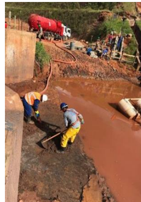
Fig. 7 – Remoção e limpeza com caminhão hidro-vácuo
