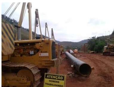
Fig. 12 – Substituição da linha tronco-4 quilômetros
