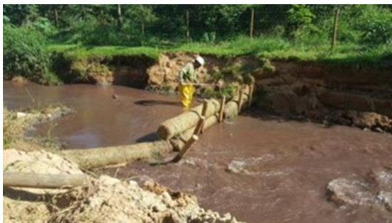
Fig. 4 – Barreiras com elemento filtrante
