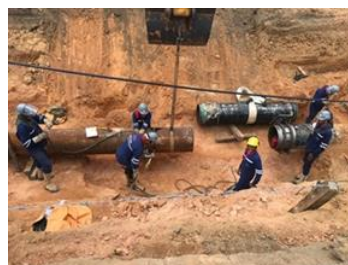
Fig. 17 – Substituição de tubo
