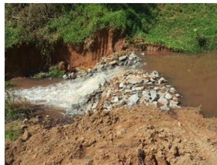
Fig. 5 – Barreiras com pedras de mão e saco solo
