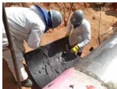
Fig. 13 – Instalação de dupla calha
